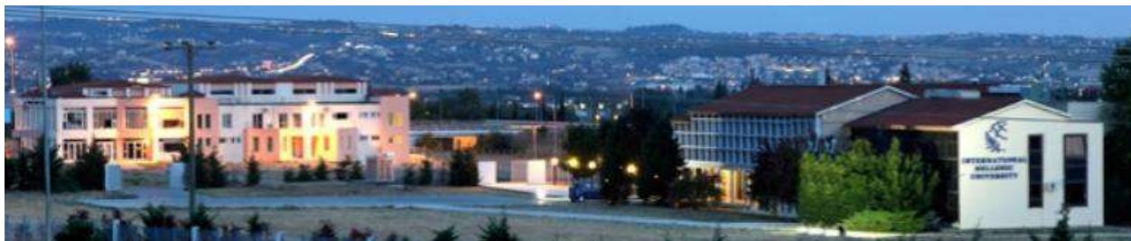
Εικόνα 1. Όψη των κτιριακών υποδομών στη Θέρμη Θεσσαλονίκης
