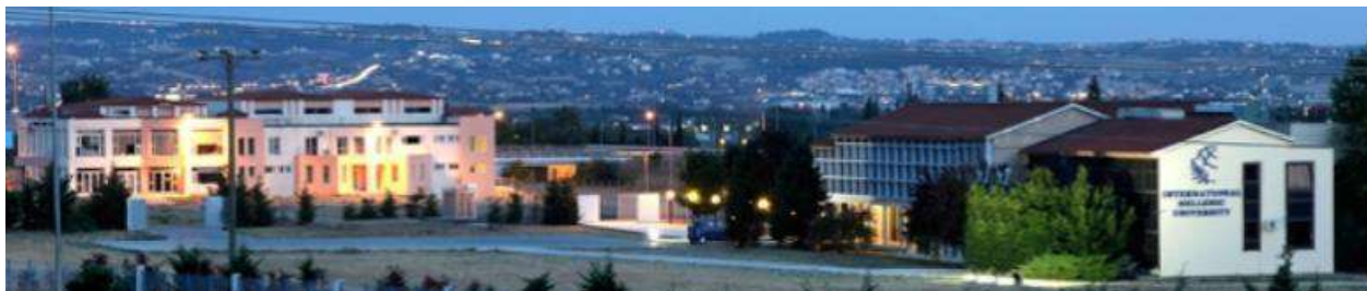
Εικόνα 1. Όψη των κτιριακών υποδομών στη Θέρμη Θεσσαλονίκης
